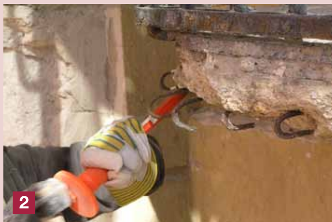
2 Почистването на отчупени, ронещи се, нездрави части се извършва с шило, секач и чук, или с къртач (внимава се да не се разрушат здрави участъци, особено при по-стари бетони). При по-големи площи почистването на основата се извършва с водоструен апарат, с добавяне на абразив.
