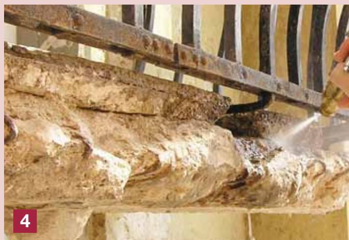
4 24 часа преди полагане на саниращия разтвор основата се измива с водна струя под налягане за премахване на прахта и се навлажнява обилно, за да се създаде впоследствие добра адхезия на саниращите материали към нея.
