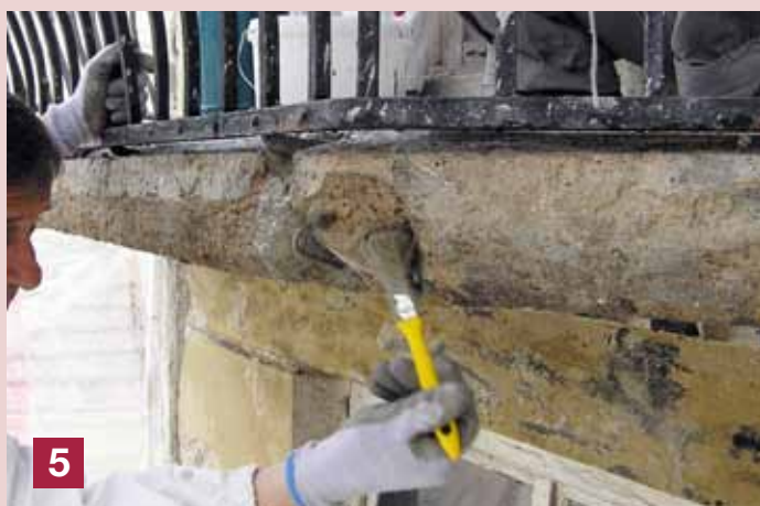
5 Железата се обмазват с разтвор за защита на армировката БетоПротект с четка – на две ръце през около мин. 6 часа.
