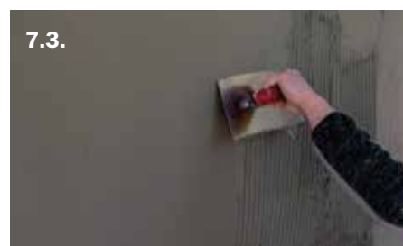
Заглаждане на повърхността на шпакловката
