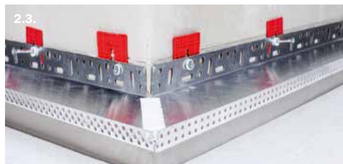
Зарязване на профили с ъглошлайф под 45° и слепването им един към друг; Подлагане на дистанционери при отклоняващи се от равнината основи
