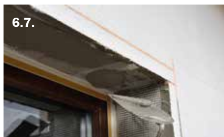
Монтаж на допълнителна ивица стъклотекстилна мрежа във вътрешните ъгли при обръщането на отвори
