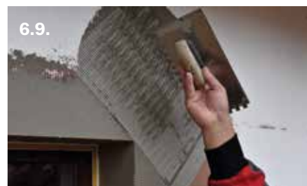
Монтаж на ивица стъклотекстилна мрежа за диагонално армиране при ъгъл на отвор
