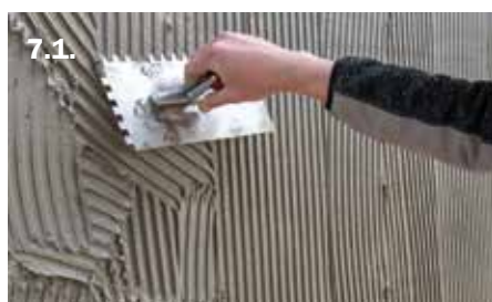
Шпакловане на топлоизолационните плочи
