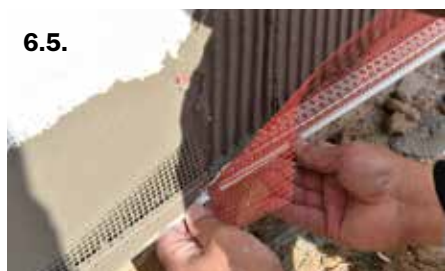
Снаждане на водооткапващи профили
