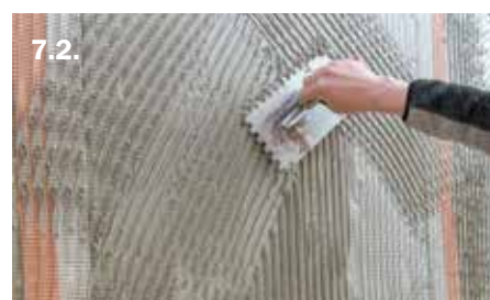
Интегриране на стъклотекстилна мрежа в шпакловката
