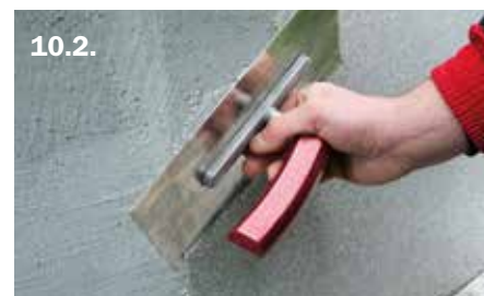
Нанасяне на Мозаична мазилка в областта на цокъла
