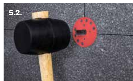
Монтаж на Дюбел
