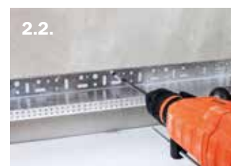
Закрепване на Цокълен профил
