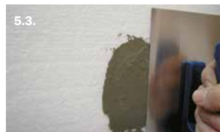
Зашпаковане на главата на дюбел
