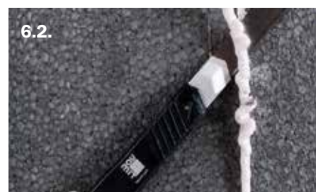
Изрязване на раздулата се извън равнината монтажна пяна
