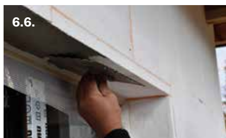
Монтаж на Профил за прозорци
