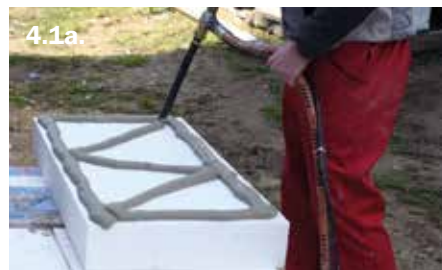
Схема на нанасяне на лепилото с машина
