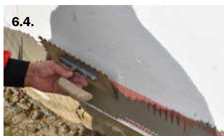
Монтаж на Профил водооткапващ
