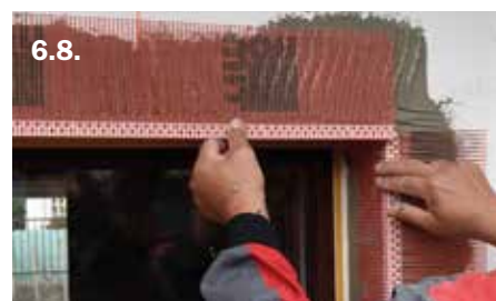
Монтаж на Профил ъглов с мрежа
