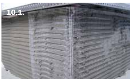
Армиране на цокълната област
