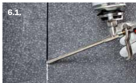
Запълване на фуги между плочите с монтажна пяна
