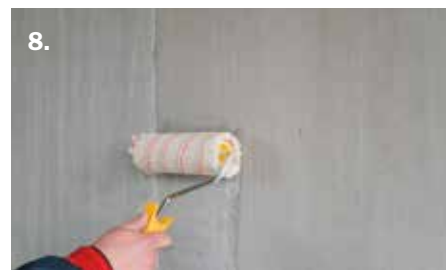
Грундиране върху армираната шпакловка
