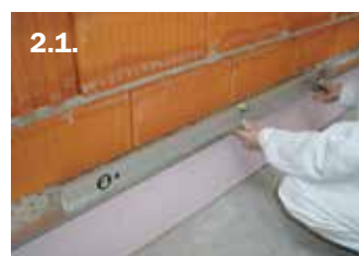
Хоризонтиране на Цокълен профил
