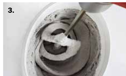
Разбъркване на лепилно-шпакловъчна смес (СтарКонтакт бял / ПроКонтакт)
