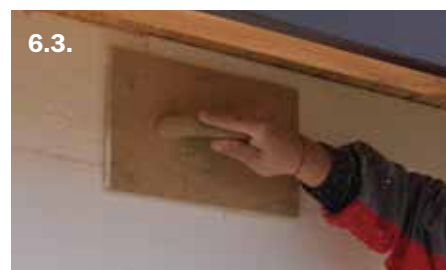
Прешлайфване на повърхността
