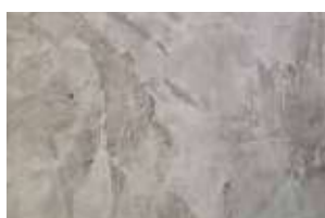
Ефект Фин Бетон
