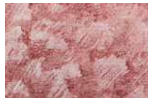
Моделиране с шпакла и изчеткване
