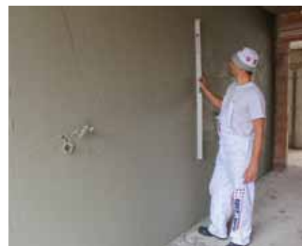
Фиг. 21 Контрол на вертикалността на изтеглената мазилка
