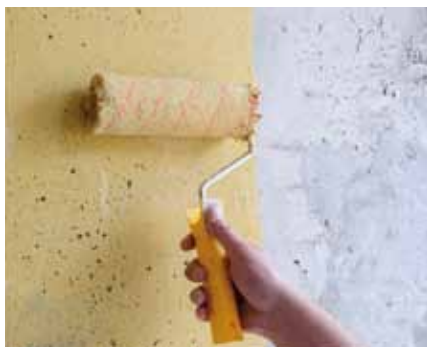
Фиг. 9 Нанасяне на Баумит БетонПраймер върху бетонова стена
