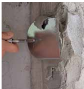
Фиг. 11 Полагане на разтвор за закрепване на ъглов профил
