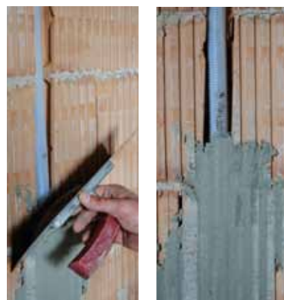
Фиг. 5 Прикрепване на кабели и затваряне на инсталационни канали
