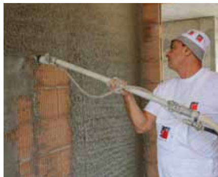
Фиг. 15 Нанасяне на машинна мазилка върху тухлена стена
