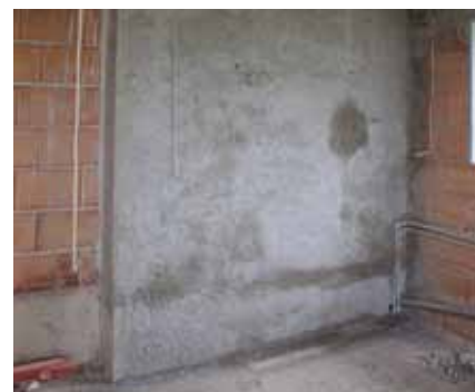
Фиг. 8 Изчакване на времето за съхнене на шприца, преди полагане на мазилката
