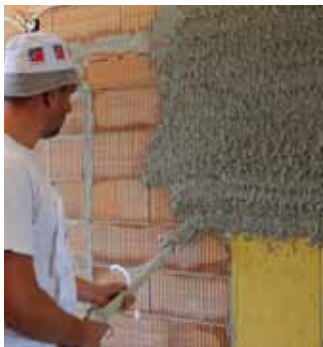
Фиг. 17 Нанасяне на ивица с мазилка при връзките между тухлена стена и бетонова колона
