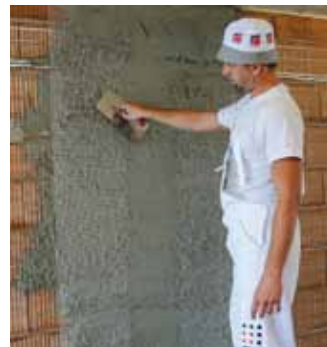
Фиг. 19 Притискане на мрежата в мазилката (с маламашка - с движения на рибена кост)
