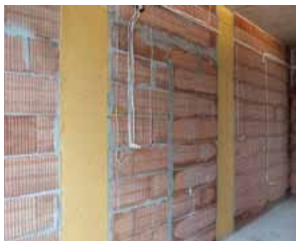
Фиг. 10 Нанесен БетонПраймер по бетонови елементи
