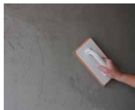
Фиг. 25 Изпердашване на мазилката
