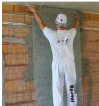
Фиг. 18 Интегриране на ивица Баумит Стъклотекстилна мрежа за машинни мазилки
