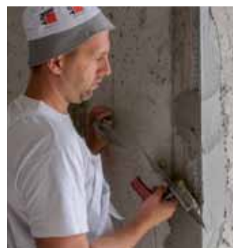
Фиг. 14 Подмазване на ъглов профил
