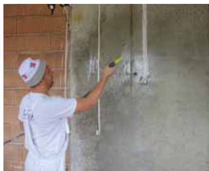
Фиг. 6 Навлажняване на основата
