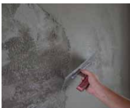
Фиг. 24 Нанасяне на втори слой мазилка (на тънко, като шпакловка)
