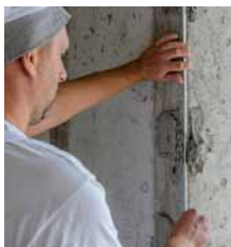
Фиг. 12 Монтиране на ъглов профил
