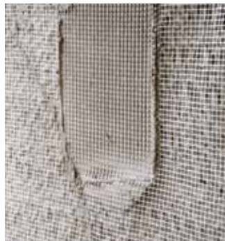
Фиг. 19 Притискане на мрежата в мазилката (с маламашка - с движения на рибена кост)
