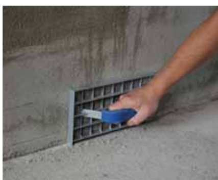
Фиг. 23 Почистване на неравности и „мустаци“ с грейдер
