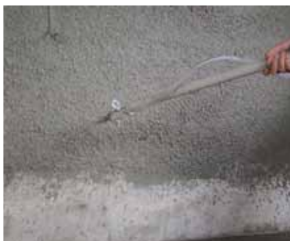
Фиг. 7 Изпръскване на шприца (100% покритие)
