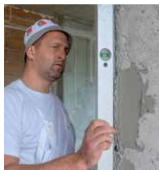
Фиг. 13 Нивелиране на ъглов профил
