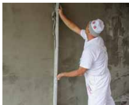
Фиг. 22 Отсичане на мазилковата повърхност
