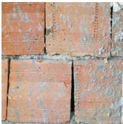
Фиг. 2 Вертикална фуга, която трябва да бъде предварително запълнена
