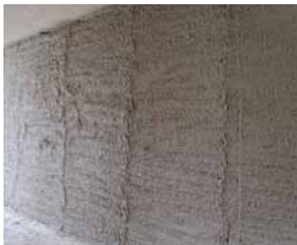
Фиг. 16 Стена с положена мазилка
