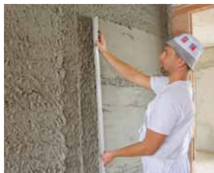
Фиг. 20 Изтегляне на слоя мазилка
