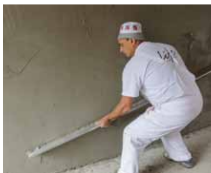
Фиг. 22 Отсичане на мазилковата повърхност
