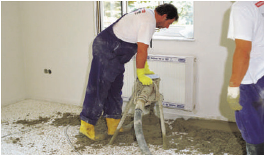
Полага се ръчно или с машини за замазки
