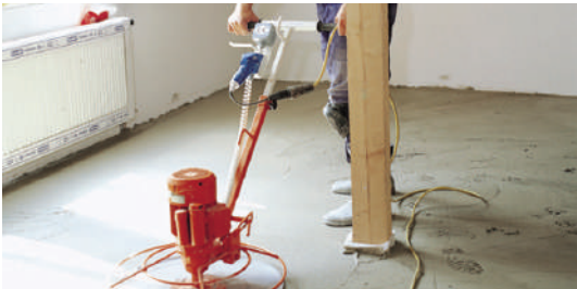
След като дръпне се загладва ръчно или се шлайфа с машина
