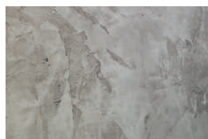
Ефект Фин Бетон
