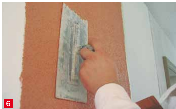
6 Решение 3б: Нанасяне на фасадна мазилка.
