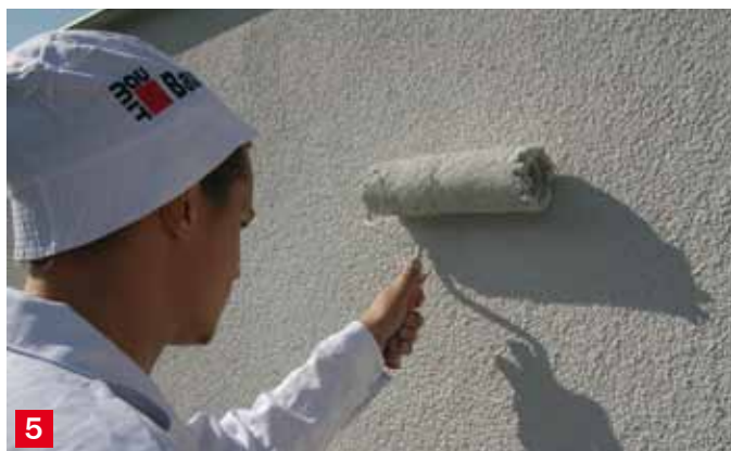
5 Решение 3а: Нанасяне на Баумит фасадна боя.
