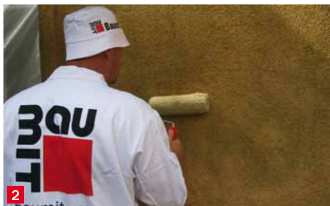
2 Предварително третиране на фасадата (при необходимост) с подходящ фунгицид (напр. Баумит ФунгоСтоп) или с Баумит Дълбочинен грунд (при силнопопиващи или ронещи се основи).
