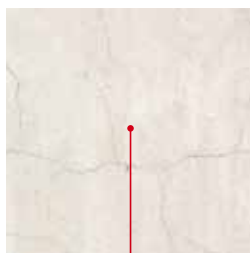
ФАСАДА С ПУКНАТИНИ ПО-МАЛКИ ОТ 0,5 мм
