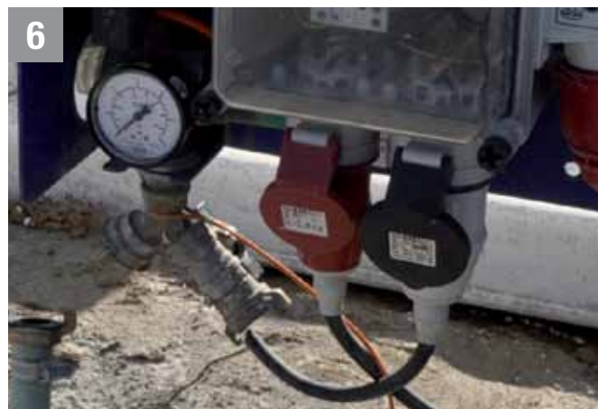
Минимално изискване за налягане на водата 2,5 бара.
