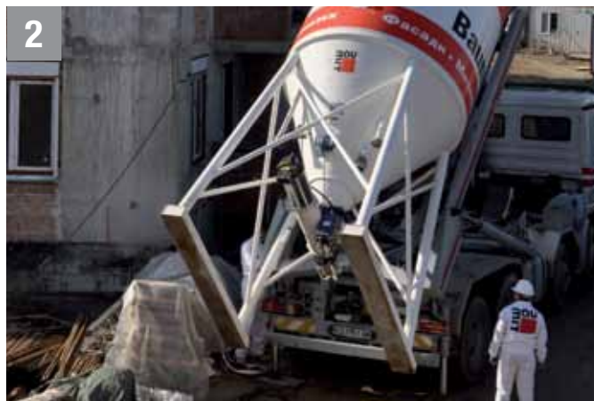
2 Върху предварително подготвената и одобрена площадка се инсталира силосът.
