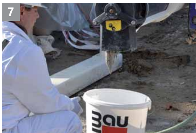
Получената смес е перфектно разбъркана, тъй като в силиконовата тръба лопатките на бъркалната работят в срещуположни посоки, което е непостижимо при работа с класически миксер.
