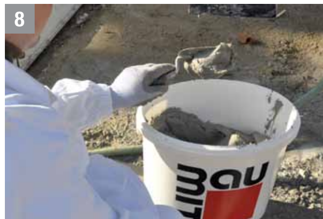
Проверка на консистенцията. За оптимална консистенция е необходимо лепилната и шпакловъчна смес да не пада и да запазва формата си при обърната надолу мистрия.
