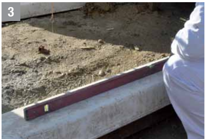
3 Задължително се проверява нивелацията на поставения силос.
