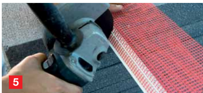
5 Рязането на профила се извършва посредством ъглошлайф.
