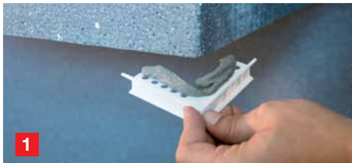
1 Баумит Външен водооткапващ ъгъл се намазва с Баумит СтарКонтакт.
