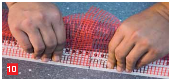
10 Конекторът се поставя в улея на профилите, след което профилите се притискат.
