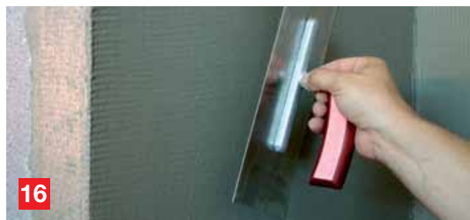
16 Заглаждане се извършва посредством обикновена неръждаема маламашка.
