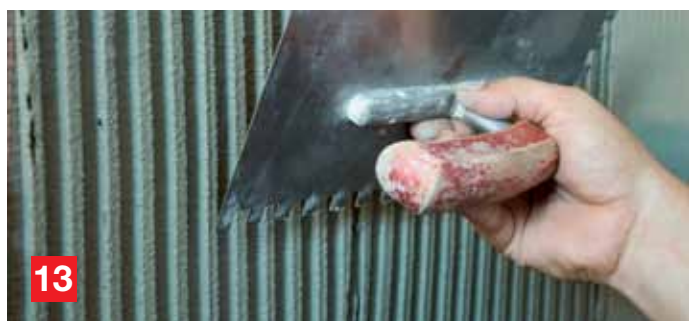
13 Цялата площ се шпаклова с Баумит СтарКонтакт, нанесен на гребен 10 мм.
