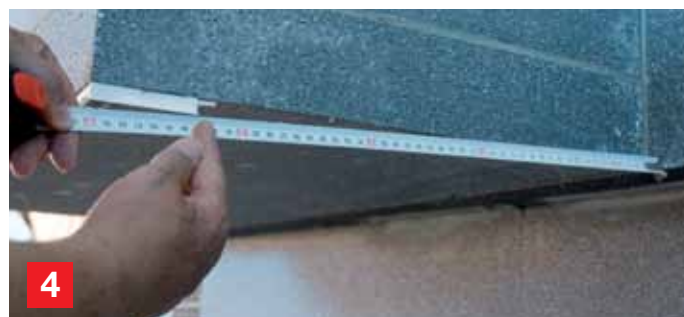
4 Измерваме необходимата дължина за Баумит профил водооткапващ.
