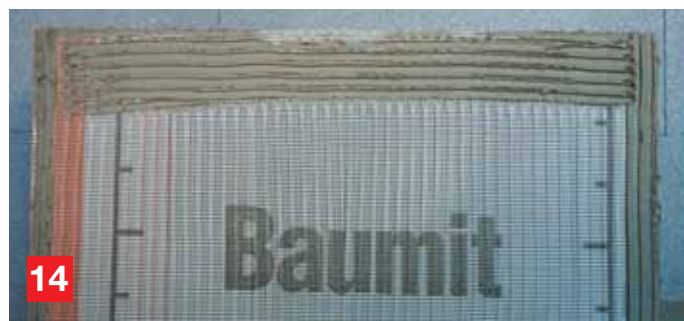
14 Баумит СтарТекс се притиска с гребеновидна маламашка към шпакловката на хоризонтална ивица в горния край.
